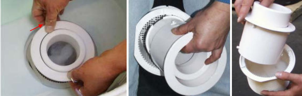
Skimmerkorb durch Links-Drehung (bis beide abgeflachte Flächen übereinander passen) aus dem Filtergehäuse nehmen
