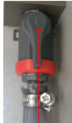
hier: Kugelhahn ist geöffnet
